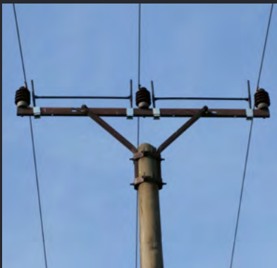
Teleskopická konštrukcia ekochárničky pre jednozávesy eliminuje rizikové plochy medzi izolátorom a prvkom. (M. G.)
