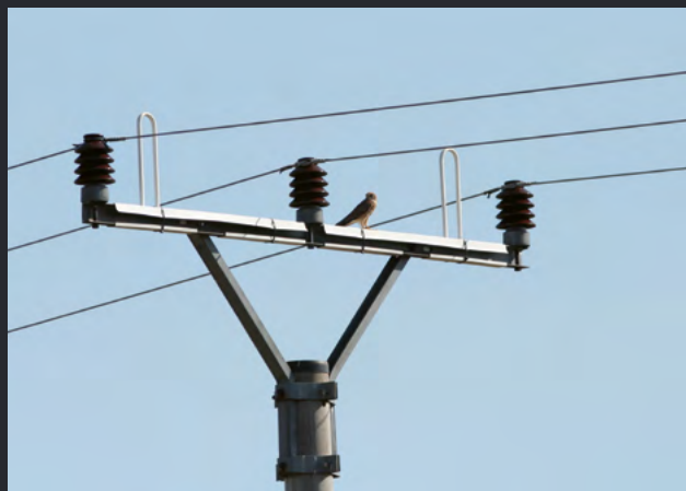
Bezpečný jednozáves vďaka ekochráničke „zub“. (K. Š.)
