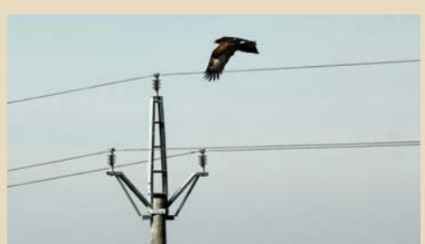
Stredoslovenská energetika – Distribúcia, a. s. zabezpečila výmenu starších typov konzol, na ktoré nebolo možné nainštalovať konzolové chráničky za speciálny typ ocelových konzol Antibird, ktoré zabezpečujú usporiadanie fázových vodičov na vrchole stĺpa tak aby sa zabránilo vtáctvu sadat do priestoru spojnice fázových vodičov, čím sa zníži riziko prípadného poranenia a úhynu vtáctva elektrickým prúdom.
